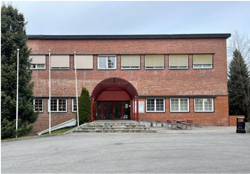
Hovedinngang til det tidligere administrasjonsbygget med klutelageret. Foto: Rebuilding
