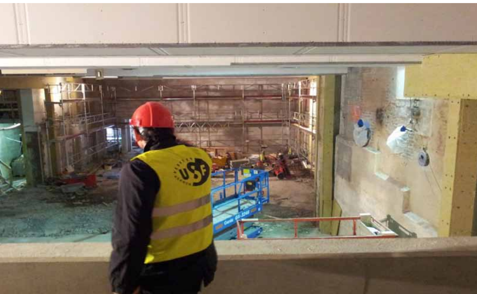
USF VERFTET - RØKERIET SCENE, BERGEN. REKONSTRUKSJON AV SCENEROMMET OG STØRRE AKUSTISKE TILTAK UNDER ARBEID.
